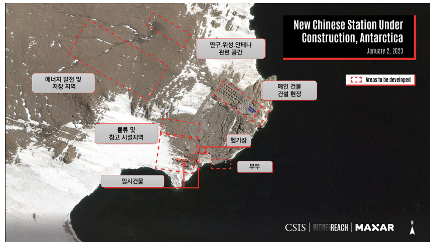
그림1. 새로 건설 중인 중국기지
