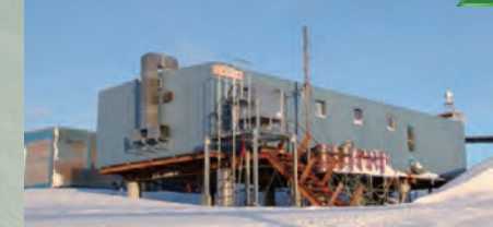
環境科学棟（1974年建設）
