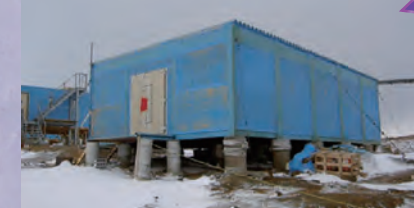
観測倉庫（1970年建設）
