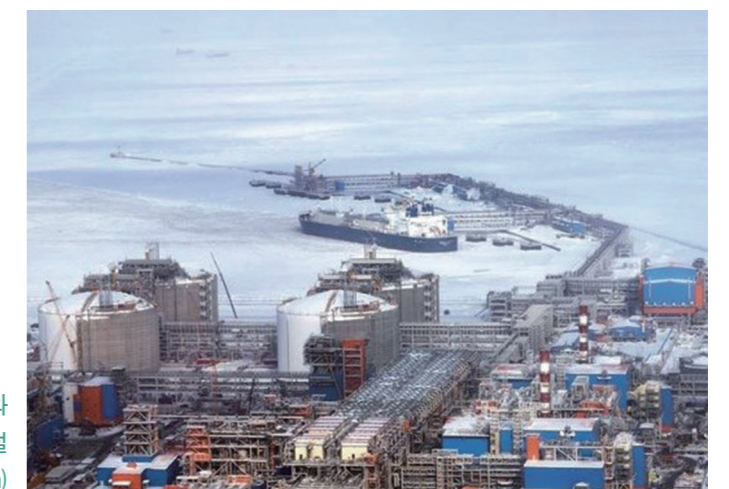
□그림 6. 야말반도 Sabetta항에 가스 액화설비와 LNG 수출터미널 (자료: Novatek 홈페이지 www.novatek.com)
